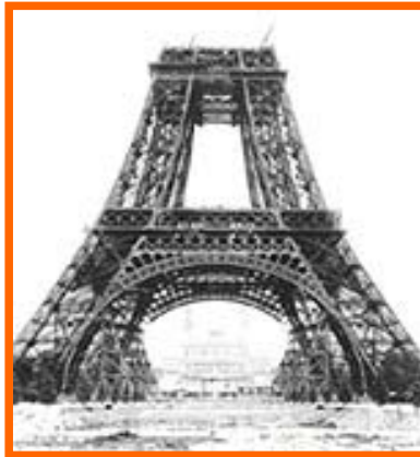
البرج أثناء التشييد
